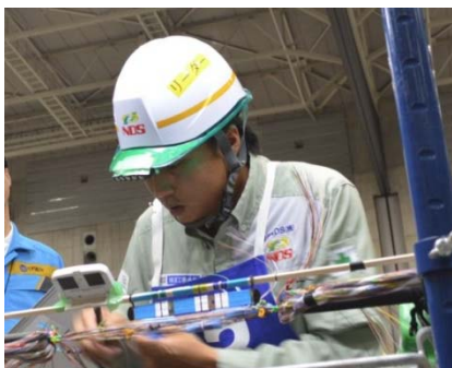
<メタル設備施工(個人)競技>
