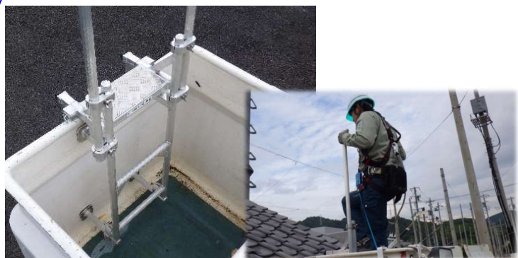
＝バケット「内側」への設置例＝
