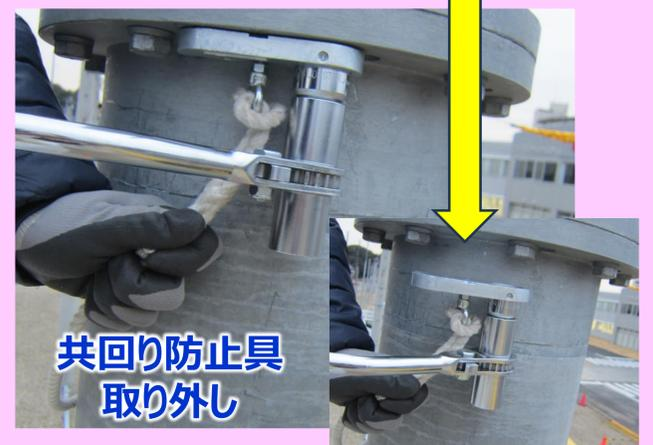
①フランジ部下面のボルトに共回り防止具を取り付けます
