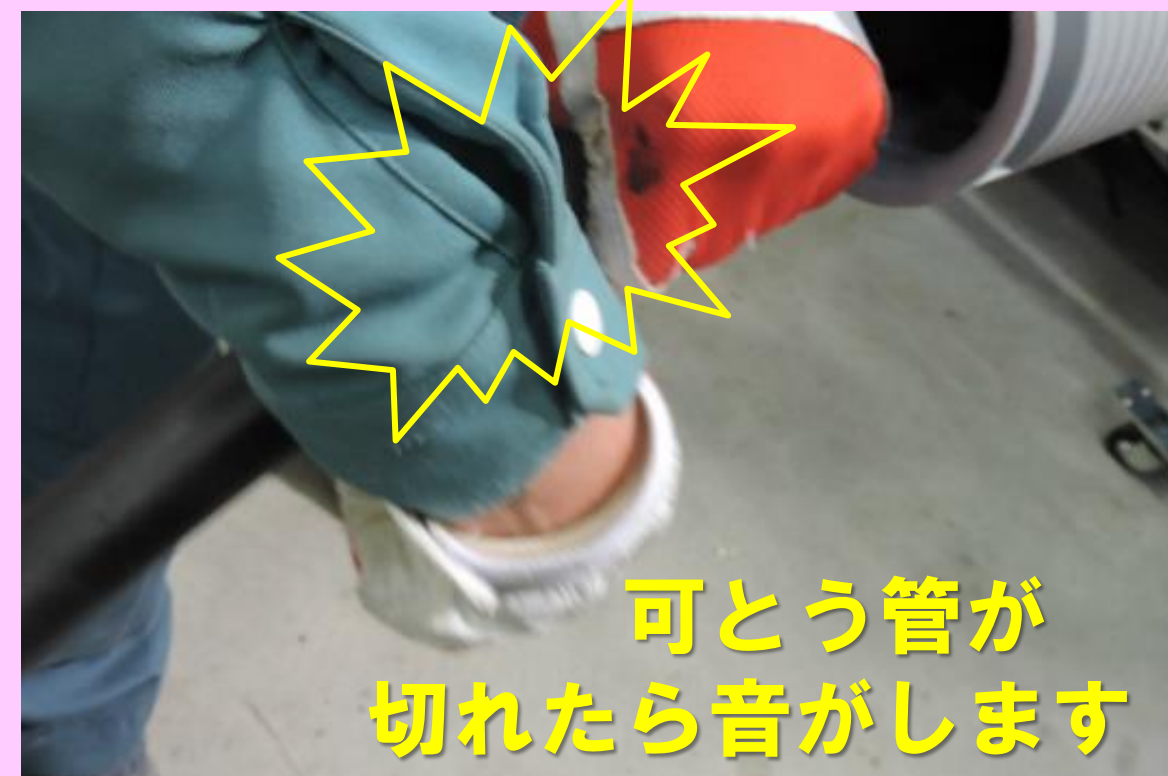
④更にネジを締め付けて もう一周刃を入れます。
