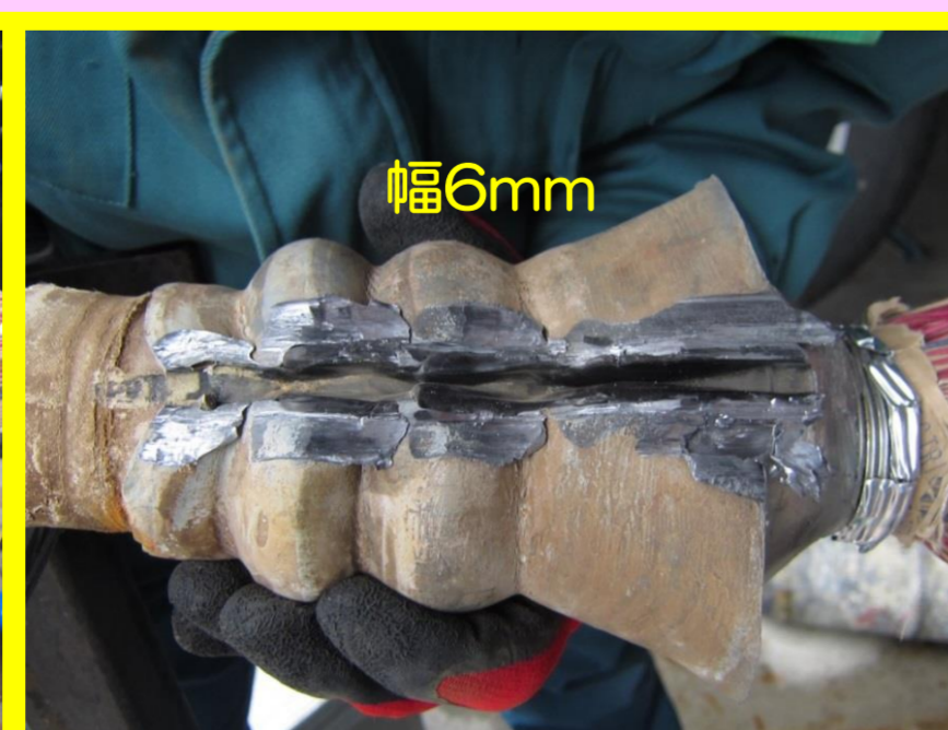
④補助鉛管の縦割り・開鉛
