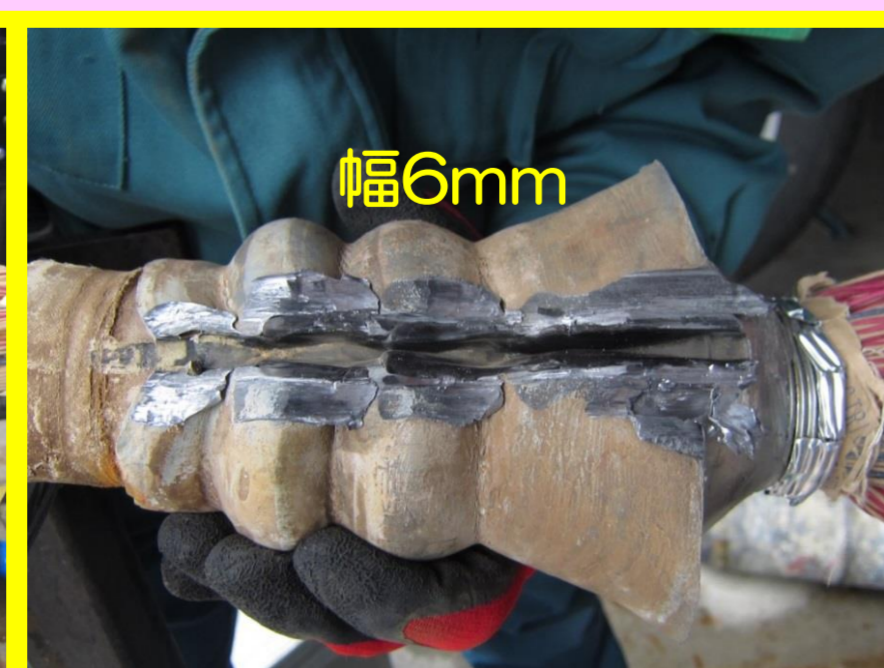
④補助鉛管の縦割り・開鉛
