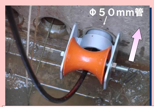
ダクトに差し込むだけでセット完了
