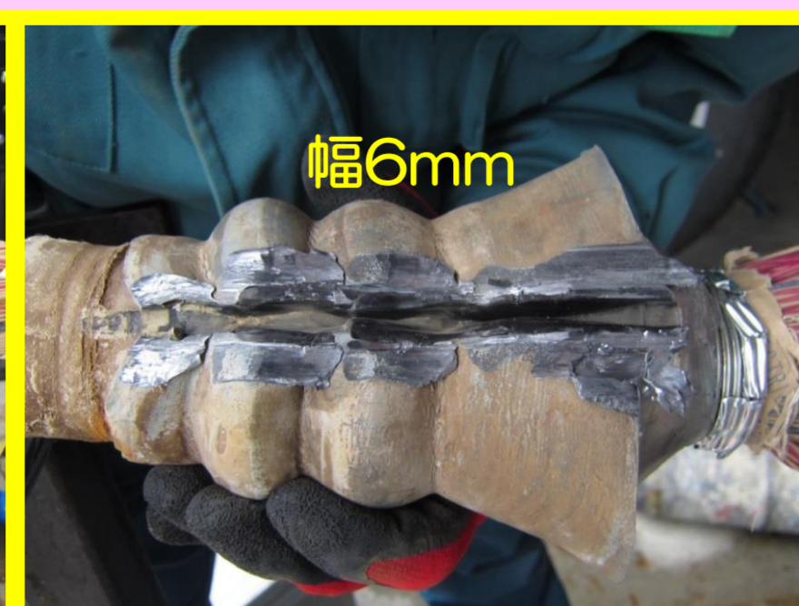
④補助鉛管の縦割り・開鉛
