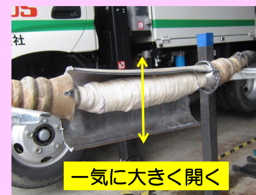
③主鉛管の除去
