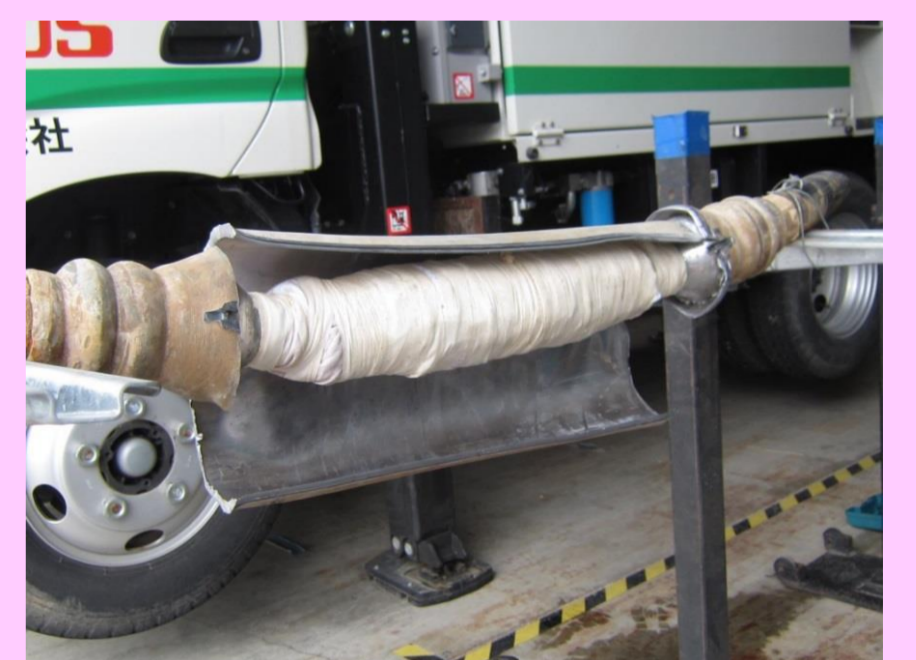
③主鉛管の除去
