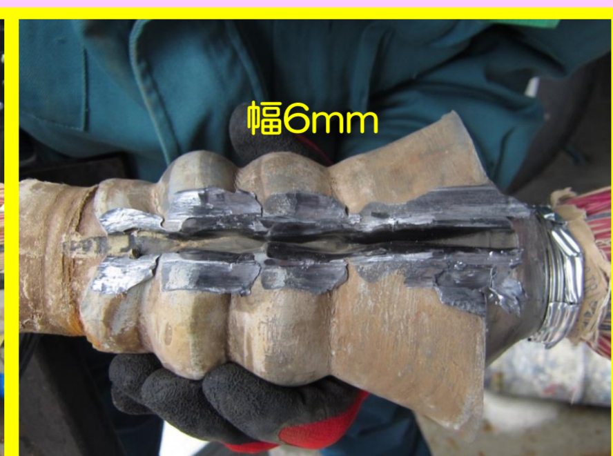
④補助鉛管の縦割り・開鉛
