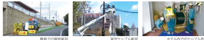
賢島での管路新設 架空ケーブル新設 ホテル内でのケーブル布設
