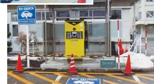
充電用スタンド設備の設置工事の様子
