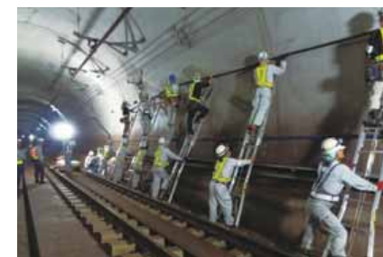
地下鉄不感地対策工事
