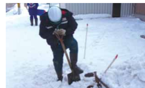
北海道での作業風景
