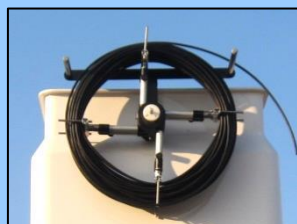
バケット設置
