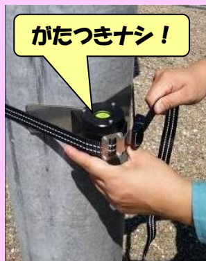
②バックル部を固定金具に掛けて締める
