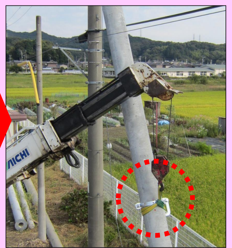
③安全施工!!
